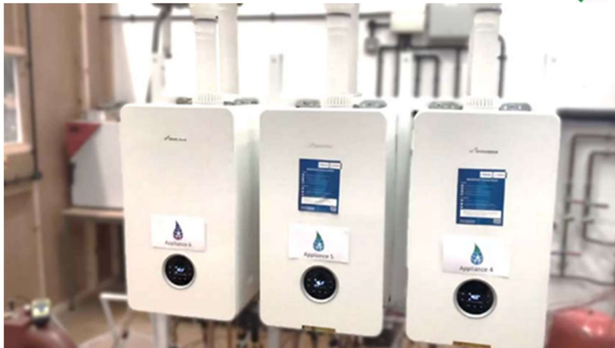
6.13. ábra: 512 kW kaszkád bojler kombi rendszer
